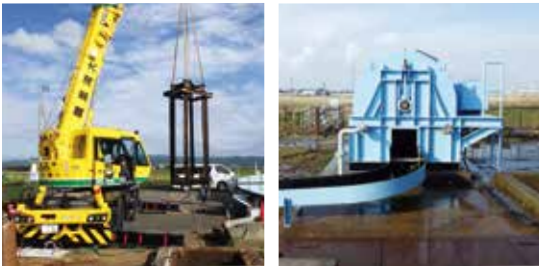
蛭沼揚水機場補修工事 (除塵機)
