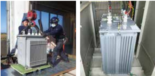
興休揚水機場電気設備交換工事
