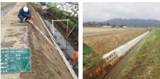
湧出川排水路護岸復旧工事
