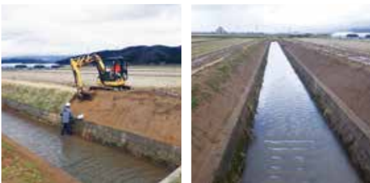
茨堰排水路 (下流) 法面補修工事
