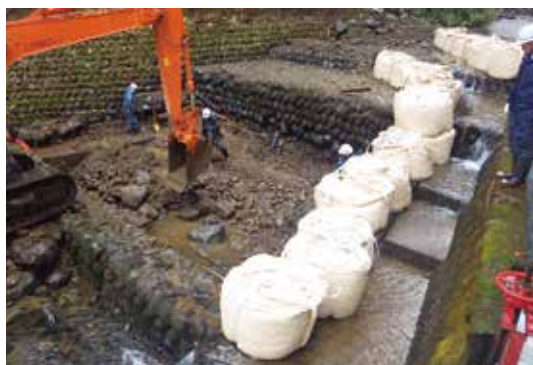
熊沢堰堤体補修工事
