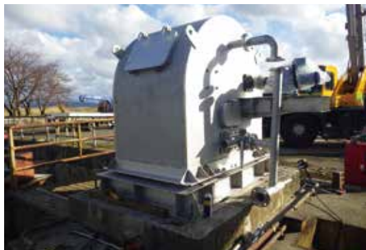
舟止揚水機場補修工事 (除塵機本体交換)
