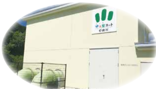
日向川小水力発電所
