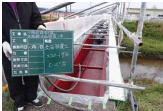
大槻幹線用水路水路橋内面被覆工事
