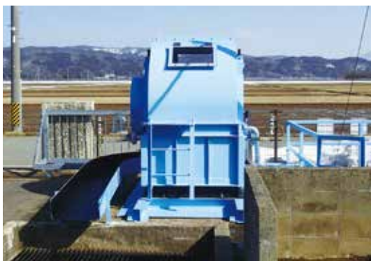
前川第二揚水機場補修工事
