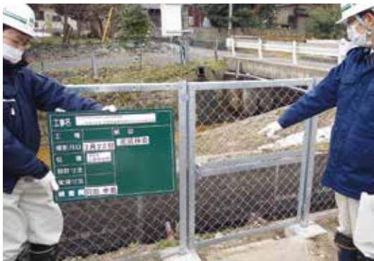
吉田幹線水路安全施設補修工事
