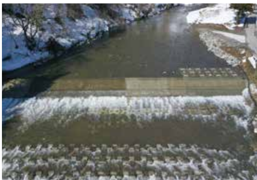
若神子頭首工改修工事 (堰堤改修外)
