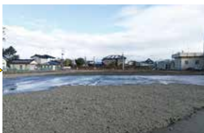
解体工事終了（2月）
