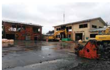
解体工事（11月～2月）
