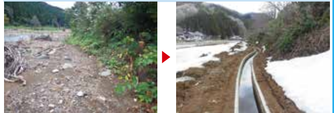
南野前田堰（取入口・水路の土砂閉塞）
