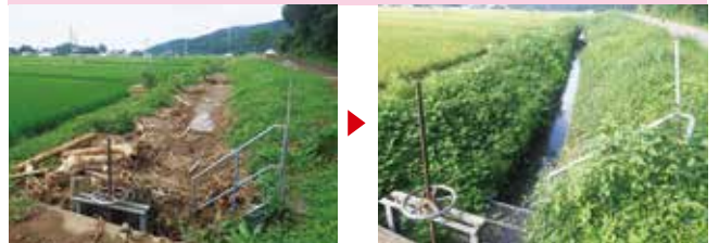
南野前田堰（取入口・水路の土砂閉塞）
